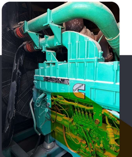
۱ دستگاه مولد دیزلی برند کامینز توان ۱۱۰۰ کیلو وات با کانوپی سوپر سایلنت و تابلو امرژنسی
