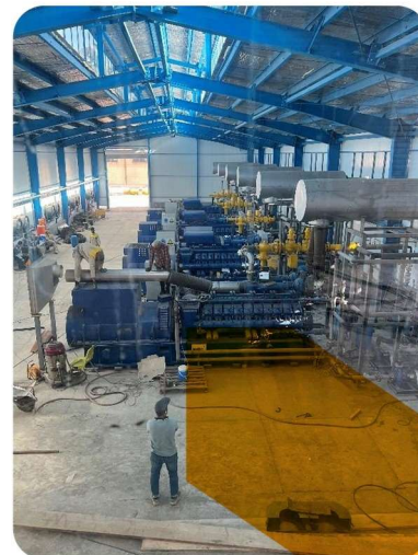
۶ دستگاه مولد MWM مدل TCG2020V20 توان ۲۰۰۰ کیلووات
