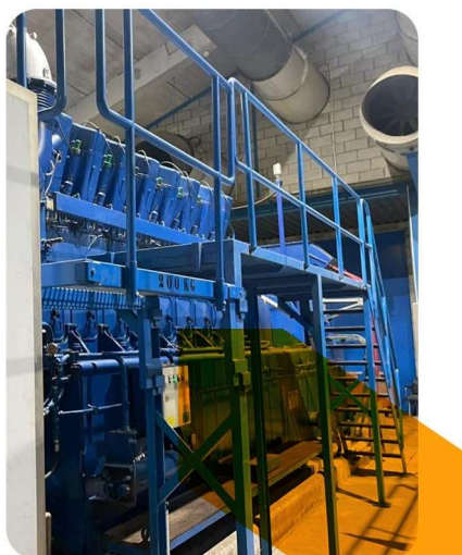
۴ دستگاه مولد MWM مدل TCG2032V16 توان ۴۳۰۰ کیلووات
