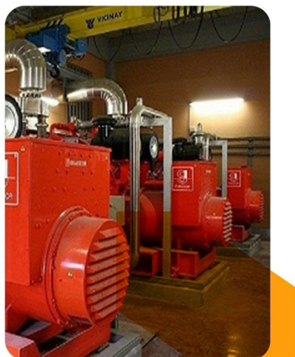
۴ دستگاه مولد GUASCOR با توان ۱۰۰۰ کیلو وات
