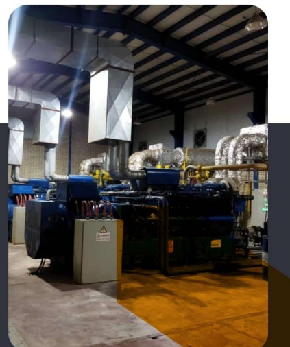
۳ دستگاه مولد MWM مدل TCG2020V20 توان ۲۰۰۰ کیلو وات
