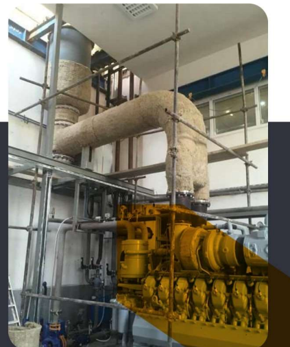
۱ دستگاه مولد MTU مدل 20V4000L62 توان ۲۰۰۰ کیلو وات
