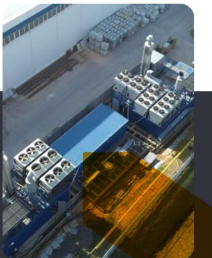
۵ دستگاه مولد MWM مدل TCG2020V20 توان ۲۰۰۰ کیلو وات
