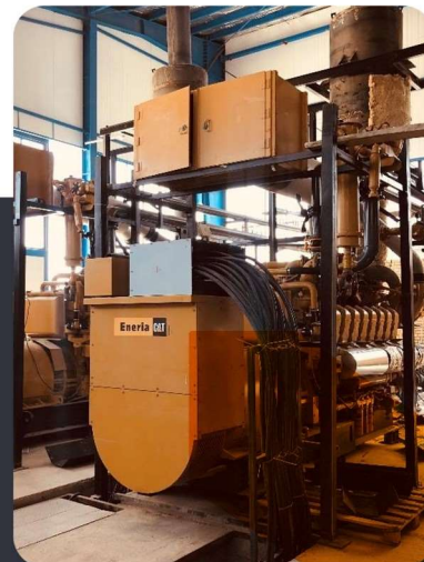
۳ دستگاه مولد برند کاترپیلار مدل 3516E توان ۱۶۰۰ کیلو وات
