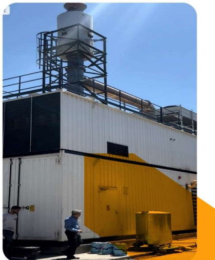
۱ دستگاه مولد کاترپیلار مدل 3520E کانتینری توان ۲۰۰۰ کیلو وات
