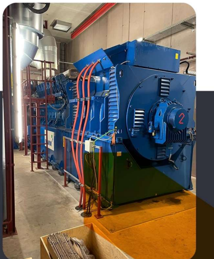
۵ دستگاه مولد برند MWM مدل TCG2032V16 توان ۴۳۰۰ کیلو وات
