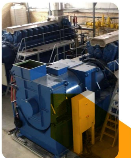
۳ دستگاه مولد MWM مدل TCG2032V16 توان ۴۳۰۰ کیلو وات
