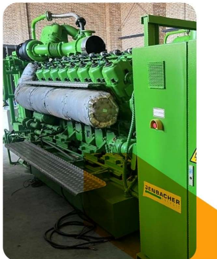
۴ دستگاه مولد یانباخر مدل J616 توان ۲۰۰۰ کیلو وات
