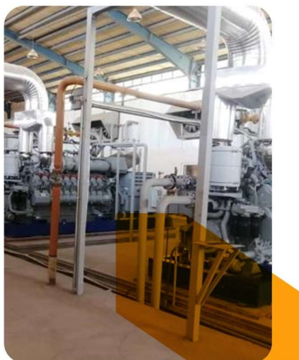
۸ دستگاه مولد MTU مدل 20V4000L32 توان ۲۰۰۰ کیلو وات
